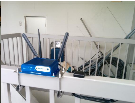
金谷防災センター
